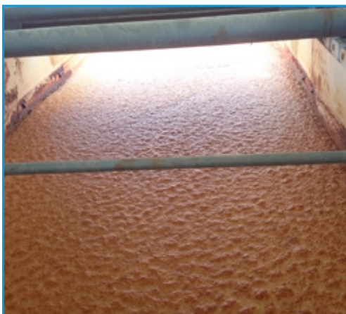
使用MicroGas™改装的DAF系统
